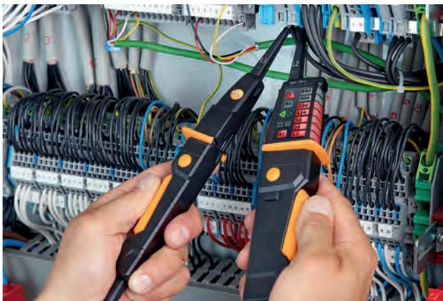
Medição da tensão no quadro de distribuição elétrica.
