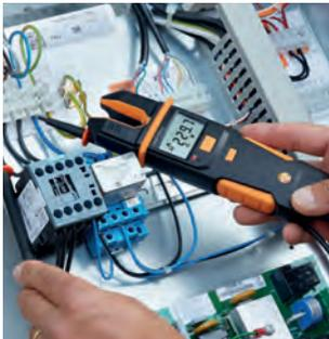
Medição de tensão em um compressor.
