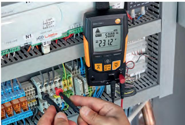
Medição de tensão no painel de ligações de uma bomba de calor.
