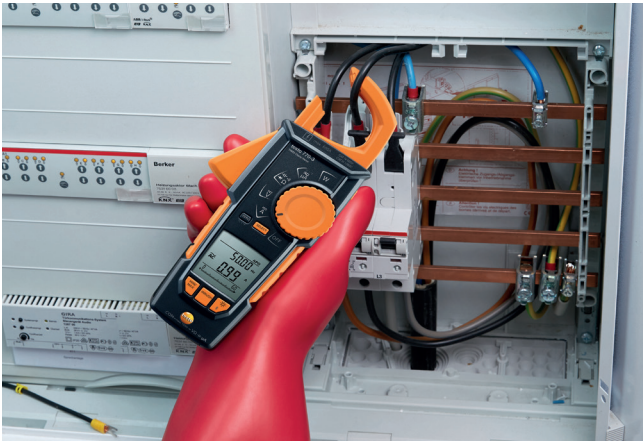
Bir şalter kabininde akımın ölçülmesi.
