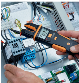
Kompresszor feszültségének mérése.
