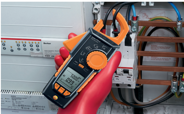
A zsúfolt kábelek között is nagyon egyszerű és megbízható az érintésmentes mérés a testo 770-3 lakatfogó segítségével. Teljesen visszahúzható fogókarja maximális pontosságot biztosít.
