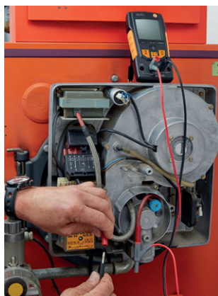
Măsurători pentru reglarea curentului de ionizare
