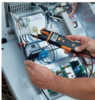
Măsurarea tensiunii pe un compresor.
