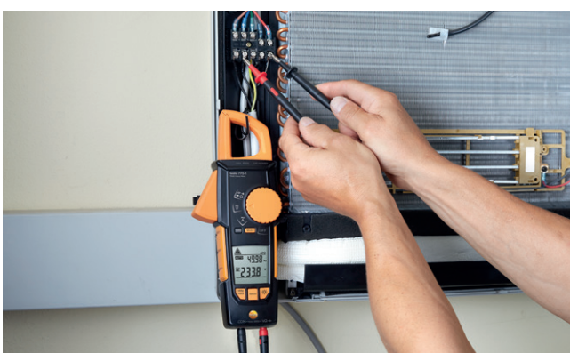
Măsurarea tensiunii pe o unitate de aer condiționat cu testo 770 .
