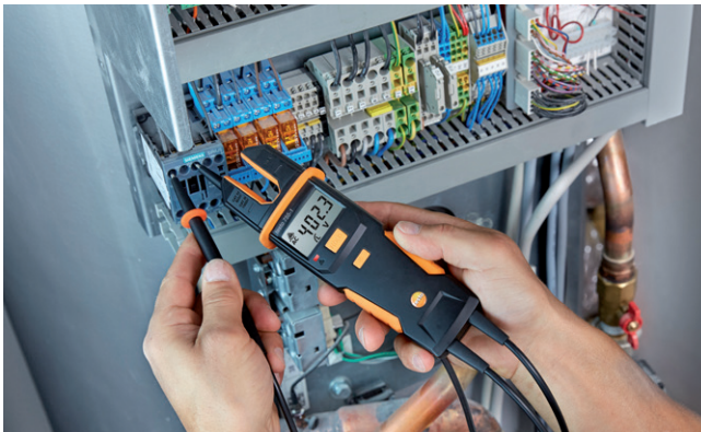
Test de tensiune pe o pompă de căldură cu testo 755 .
