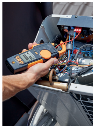
Prinderea cablului cu cleștele ampermetric într-o unitate de refrigerare exterioră
