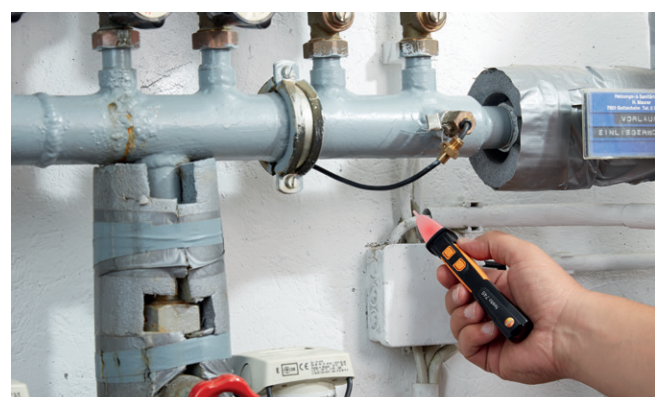
Verificarea tensiunii fără contact cu testerul de tensiune testo 745 .
