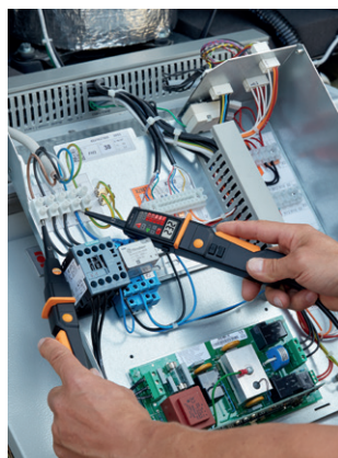
Măsurarea tensiunii pe un compresor.
