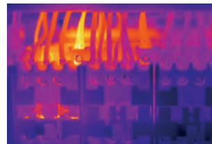
Údržba zařízení: rozpoznání příliš vysokých teplot na pojistkách a elektrických součástkách dříve, než dojde k výpadkům.
