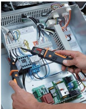
测量压缩机电压
