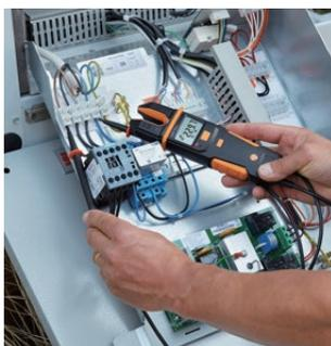
测量压缩机电压
