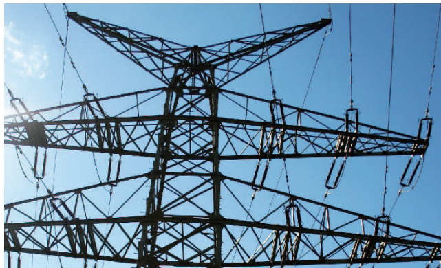
Verificarea conexiunii cu clemă pe izolator
