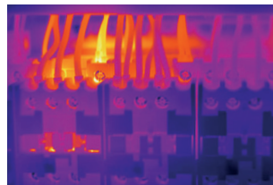
Întreținerea instalațiilor: identificați temperaturile excesiv de ridicate din disjunctoare și componente electrice înainte de apariția defecțiunilor.
