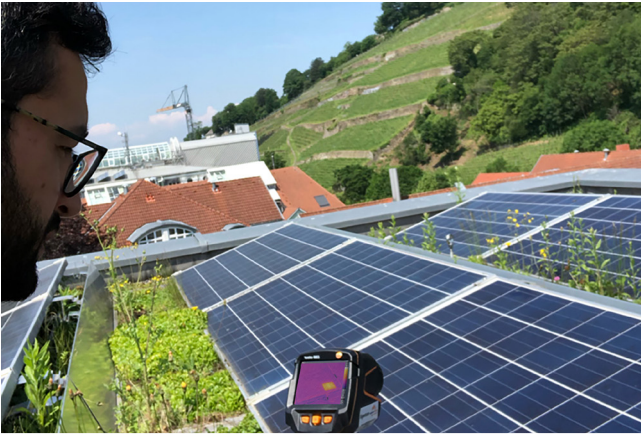
Figura 3: Inspectarea unui sistem fotovoltaic.
