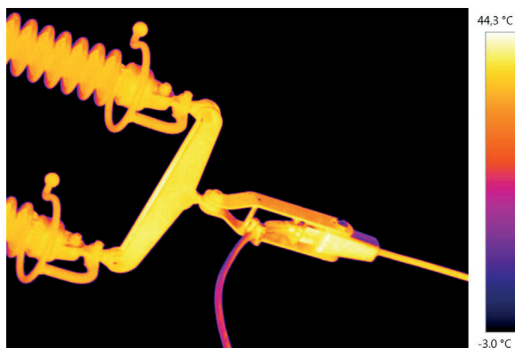
Sprawdzanie połączenia zacisku na izolatorze
