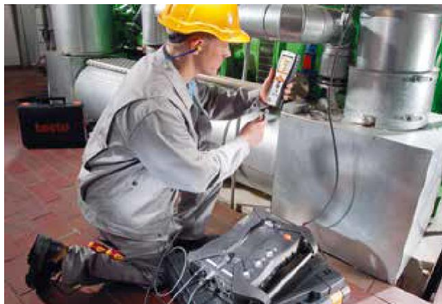
Przygotowania do pomiarów kontrolnych na instalacji kogeneracyjnej, za pomocą analizatora spalin testo 350.
