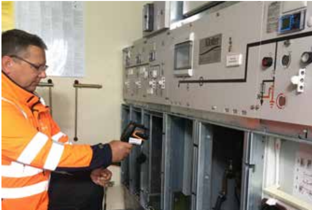
高圧スイッチギアの熱画像測定
