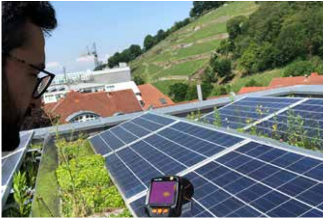
testo 883 を太陽光発電システムの点検に使用
