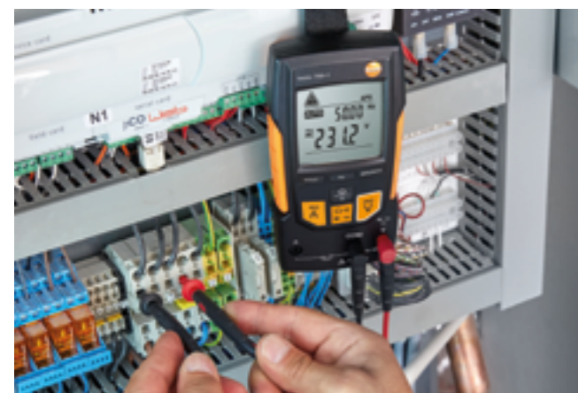
Controllo della tensione in scatole di commutazione di pompe di calore.
