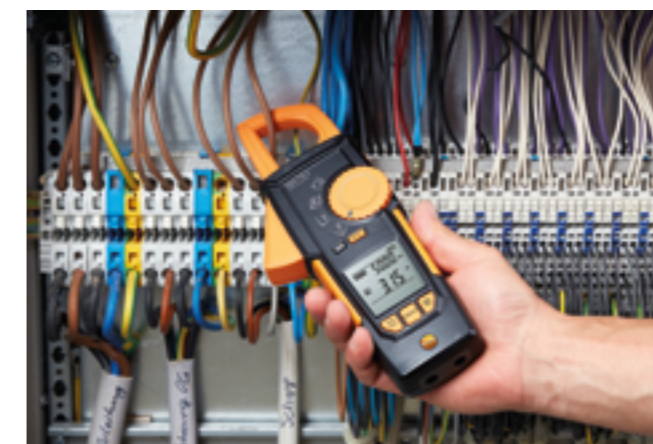
Misurazione della corrente su un quadro elettrico.
