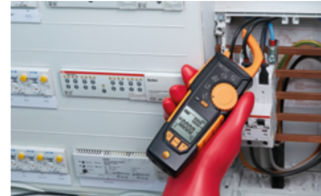
Controllo della tensione su una pompa di calore con testo 755-2 .
