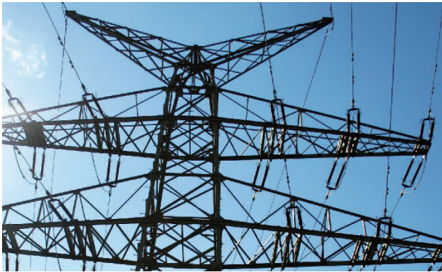
Controllo del morsetto sull'isolatore
