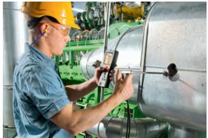
图2：testo 350 对发动机的烟气组分进行测量
