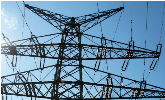
Überprüfung der Klemmverbindung am Isolator
