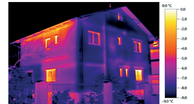
Horizontale und vertikale Wärmebrücken eines Gebäudes.
