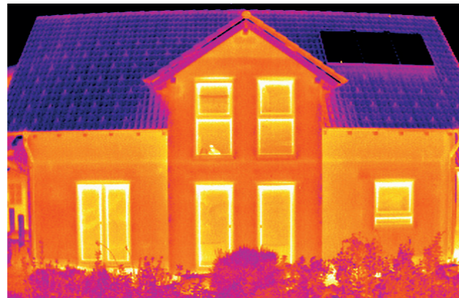
Komplette Gebäudefront in Panorama-Aufnahme.
