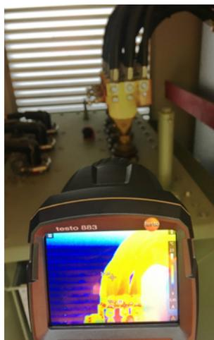
Figure 2 : Thermogramme du raccordement d'un transformateur (20 000 volts à 400 volts) via un câble basse tension.
