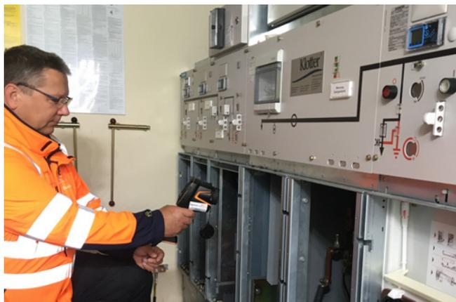
Figure 1 : Mesure par thermographie sur une installation de distribution moyenne tension.
