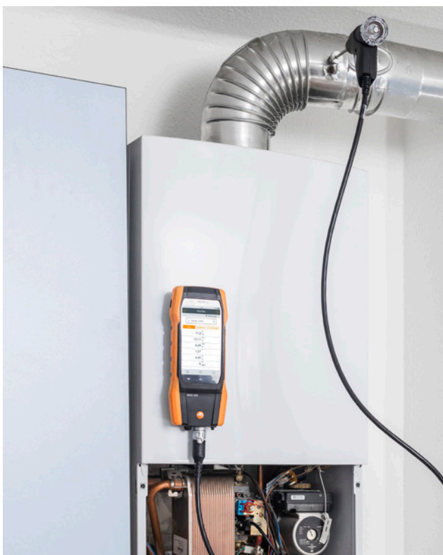
Voor het instellen is een rookgasanalyser, bijv. testo 300i, onmisbaar
