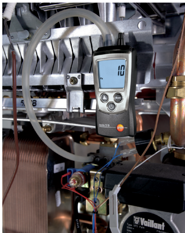
Aflezen van gasaansluit- en nozzeldruk op testo 510
