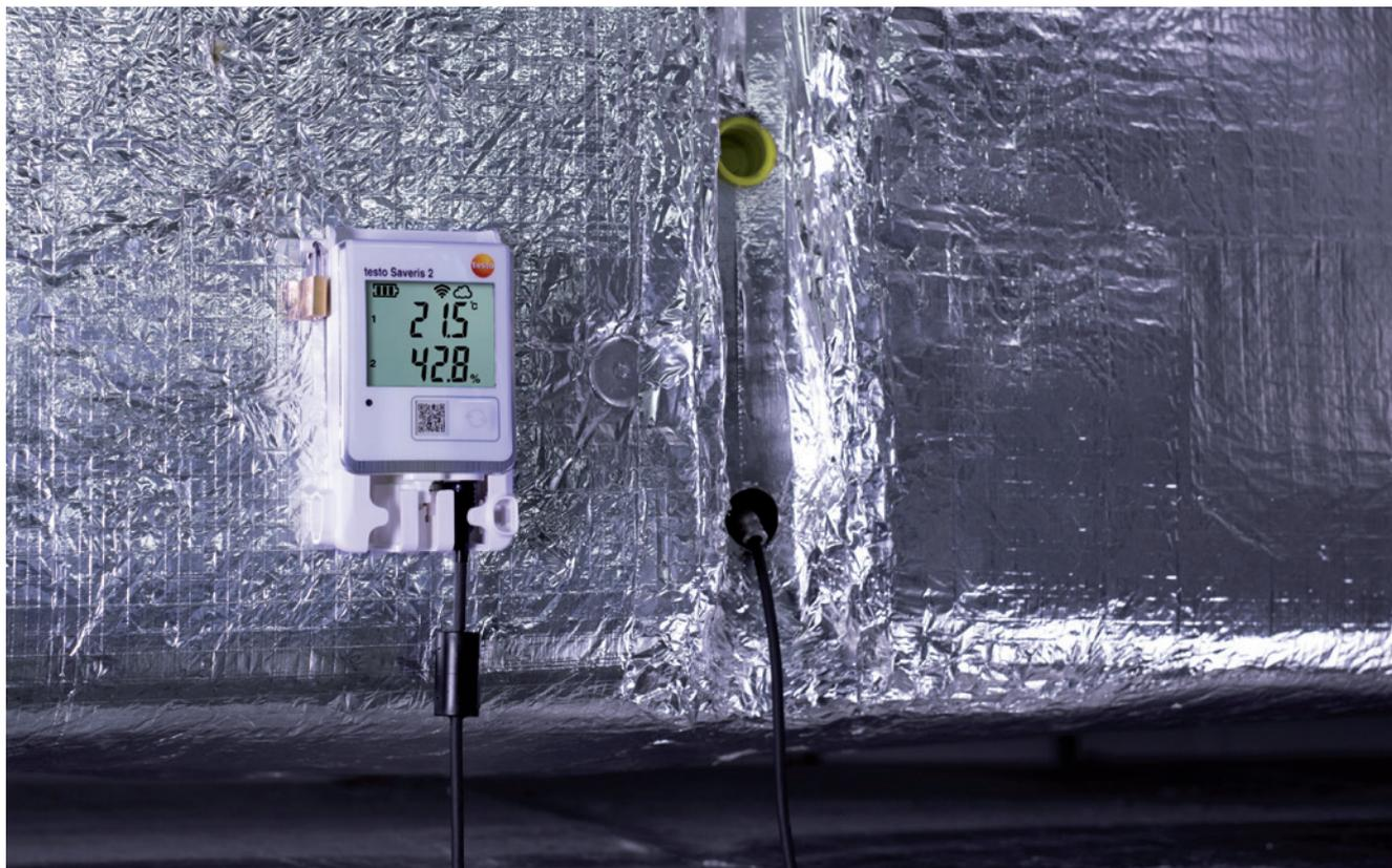
Ein testo Saveris 2-Funkfühler misst Temperatur und Feuchte in einem Lüftungskanal.
