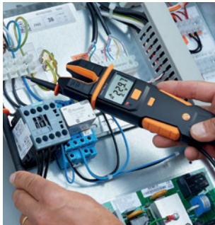
Voltmeting bij een compressor.
