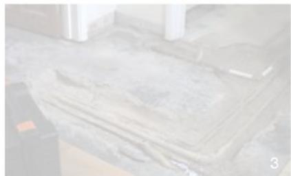
In diesem Fallbeispiel hatten klassische Methoden versagt, und Testo wurde gebeten, die Leckage mit einer Wärmekamera nachzuweisen. Für diesen Einsatzbereich eignen sich am besten die Geräte testo 885, testo 886, testo 871, testo 872 und testo 873. So konnte der Leitungverlauf über die freigelegten Bereiche hinaus erfasst werden. Innerhalb kurzer Zeit wurde
