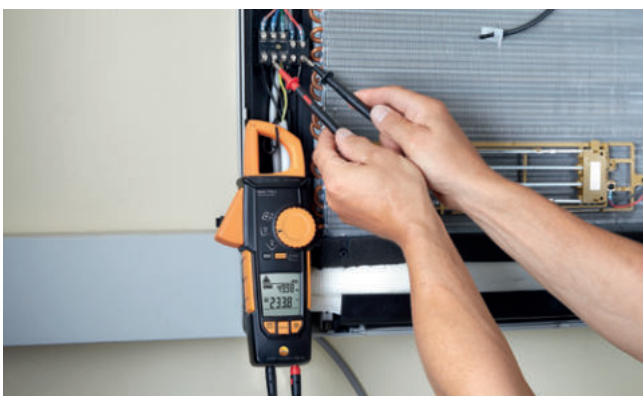
Spannungsmessung an einem Klimagerät mit testo 770 .
