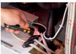
Erstprüfung der Spannungsversorgung an einem Verdichter.
