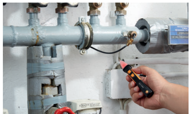
Spannungsüberprüfung an einer Verteilerdose mit testo 745 .
