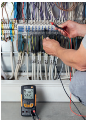
Spannungsprüfung am Schalt-schrank.
