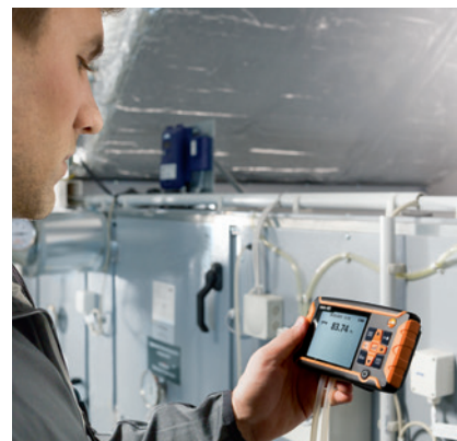
Medición de presión diferencial con manguito de conexión
