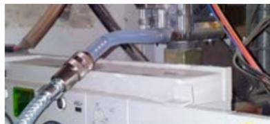
Gebrauchsfähigkeitsprüfung mit dem Adapter über die Gastherme
