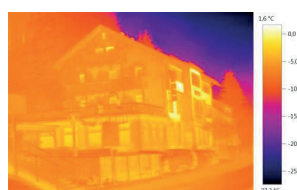
Imagem térmica sem ScaleAssist
