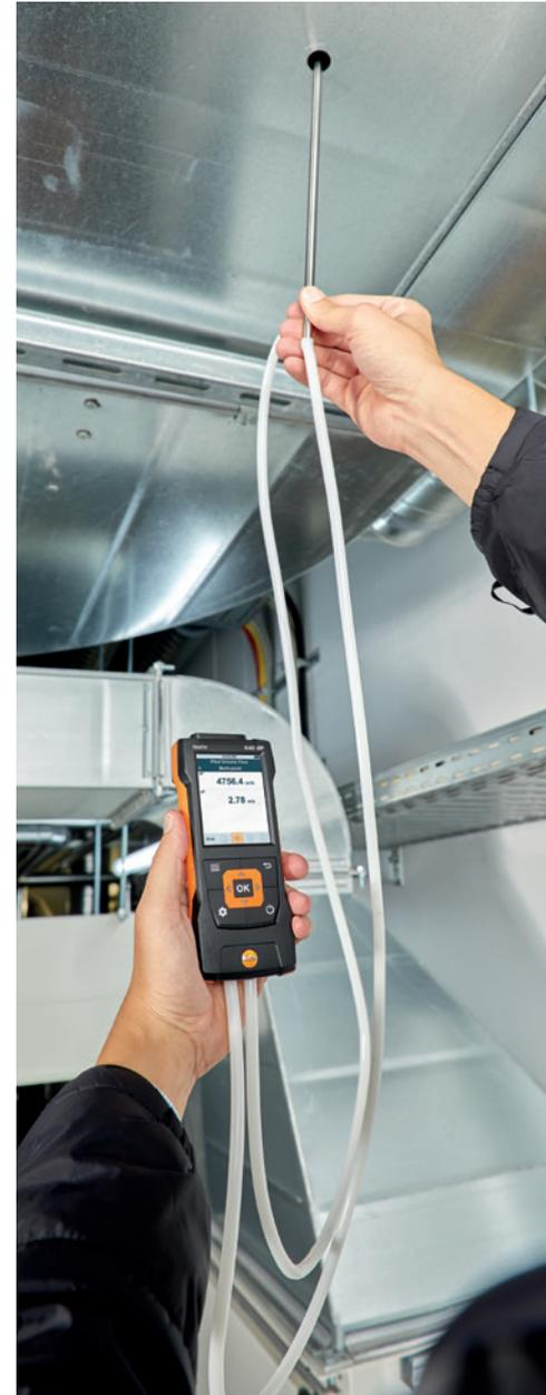
Nous recommandons d'utiliser le testo 440 dP avec un tube de Pitot pour mesurer le débit volumétrique lorsque les vitesses d'écoulement sont élevées ou lorsque l'écoulement est fortement encrassé.
