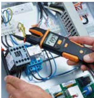
Pomiar napięcia na sprężarce.
