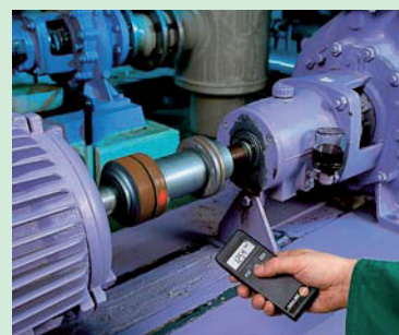
Pomiar prędkości obrotowej na wałach, rolkach za pomocą testo 465
