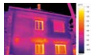
Warmtebeeld met testo ScaleAssist
