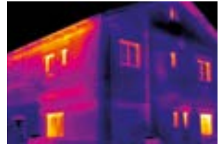
Energieverliezen van gebouwen opsporen: koudebruggen bij gevels of in een gebouw meteen detecteren en afbeelden.
