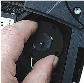
4. Motor der Kondensatförderpumpe lösen (kurze Drehung gegen den Uhrzeigersinn).
