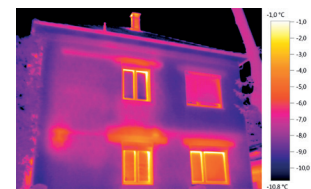
Immagine termografica con ScaleAssist
