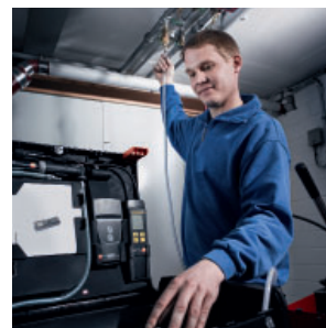
Prova di tenuta su tubazioni per acqua potabile e acque di scarico con sensore esterno 25 bar
