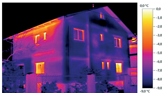
Horizontális és vertikális hőhidak egy épületen.
