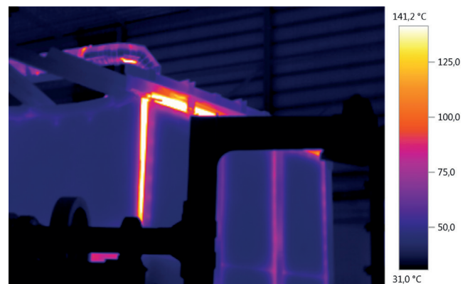
Ipari kemence hibás szigeteléssel.
