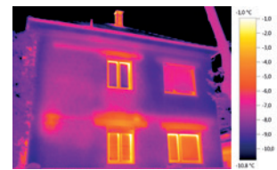
Wärmebild mit testo ScaleAssist
