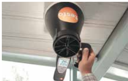
Contrôle de l'air neuf sur bouche de soufflage avec un anémomètre testo 417 et un cône de 200 mm.
