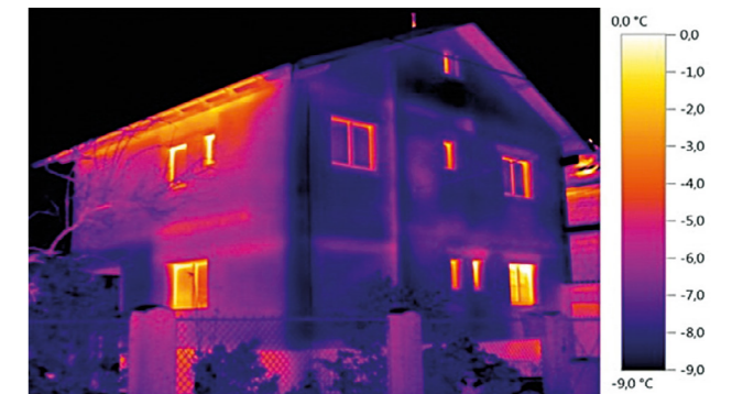
Horizontale und vertikale Wärmebrücken eines Gebäudes.
