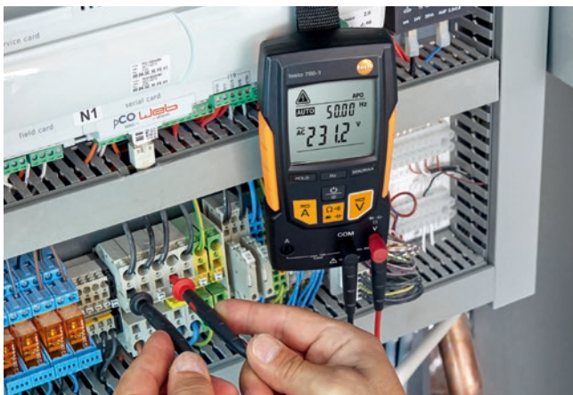
测量开关柜电压
