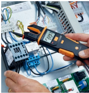
测量压缩机上的电压
