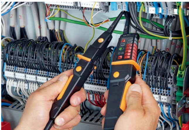
测量开关柜中的电压
