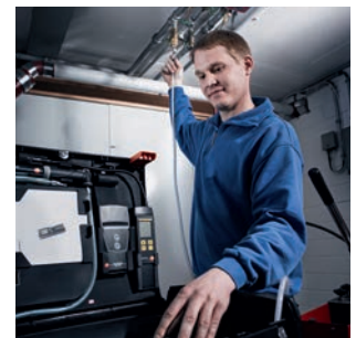
Trink- und Abwasserleitungsprüfung mit Hochdrucksonde bis 25 bar
