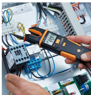
Mesure de tension sur un compresseur.
