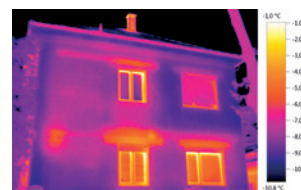
Wärmebild mit testo ScaleAssist
